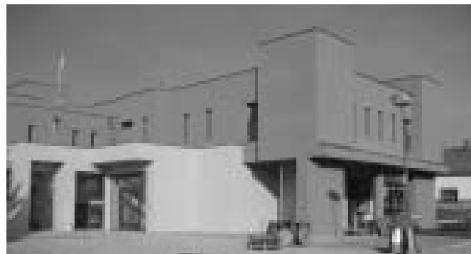
V budově a v okolí nové mateřské školy probíhají dokončovací práce.
