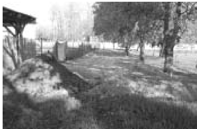
Kaštanka - když se staví bazén, musí alej stranou. Problém s nadbytečnou zeminou byl jednoduše vyřešen.
