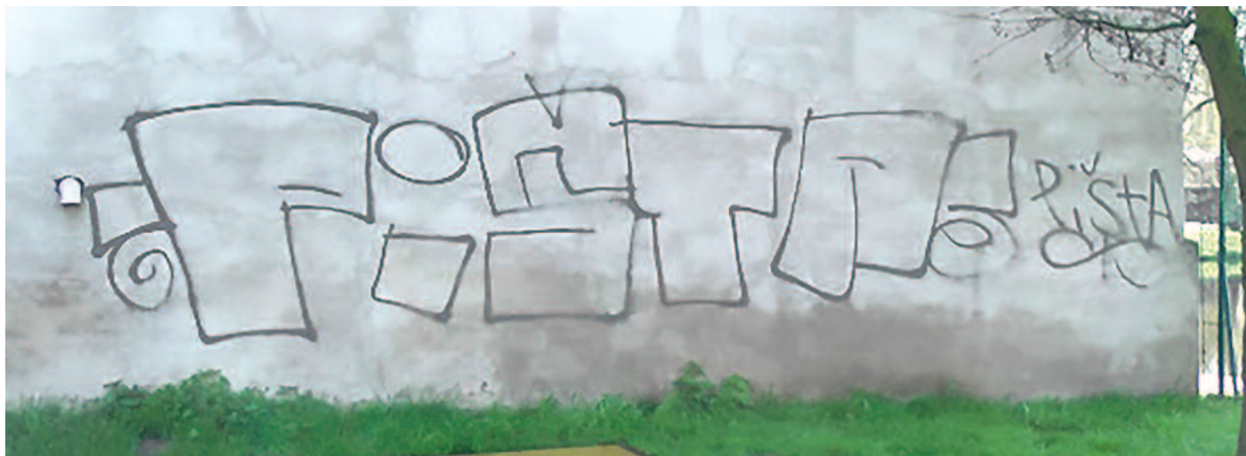
Velkoplošný domovní nápis s plynulým pokračováním na zdi.
