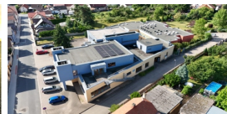
Fotovoltaika na MŠ
